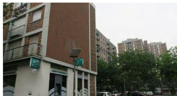
Avant la réhabilitation
