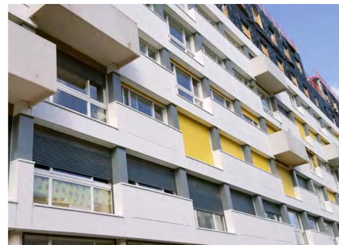
Pendant la réhabilitation
