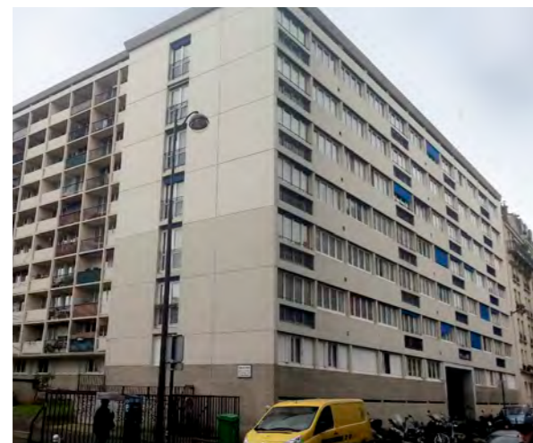
Avant la réhabilitation
