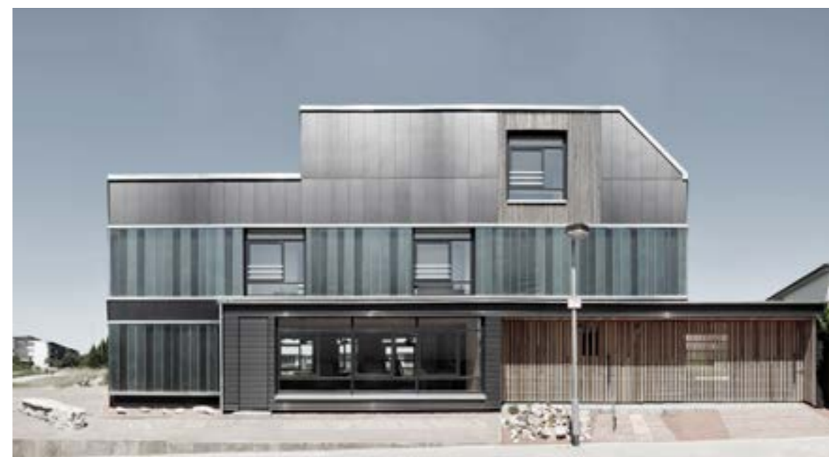
... et réutilisés pour le bardage d'une habitation (recyclée à 90 %).
